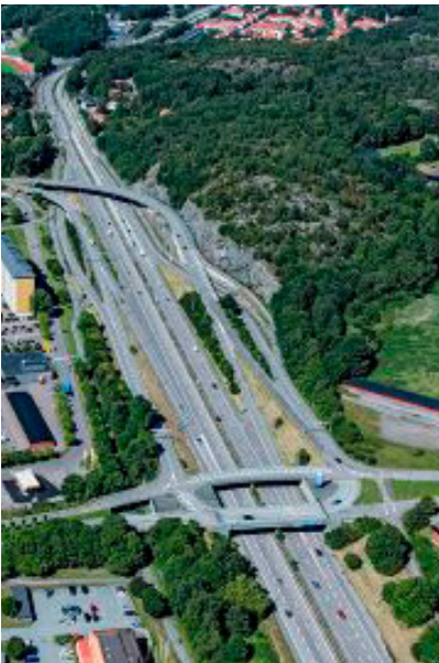
Bildkälla: Stadsbyggnadskontoret, Göteborgs Stad
