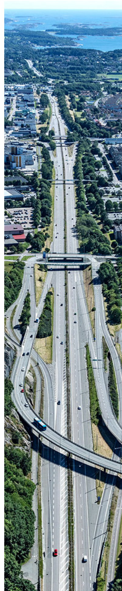
Bildkälla: Stadsbyggnadskontoret, Göteborgs Stad
