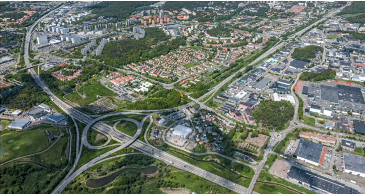
Bildkälla: Stadsbyggnadskontoret, Göteborgs Stad
